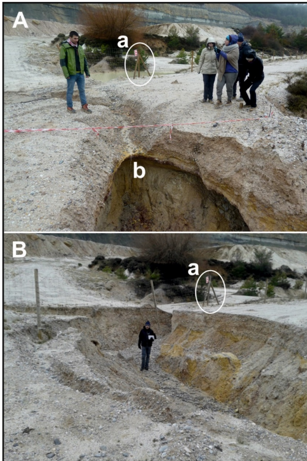
Figura 5. Erosión remontante de una cárcava que ha cortado una pista en la mina Nuria. (A) Detalle del “escalón” o knickpoint (b) que define el avance hacia aguas arriba (enero 2016); (B) vista de cómo la erosión ha terminado cortando la pista (febrero 2017); (a) poste de madera usado como referencia. Figura extraída de (Zapico et al., 2021c).
