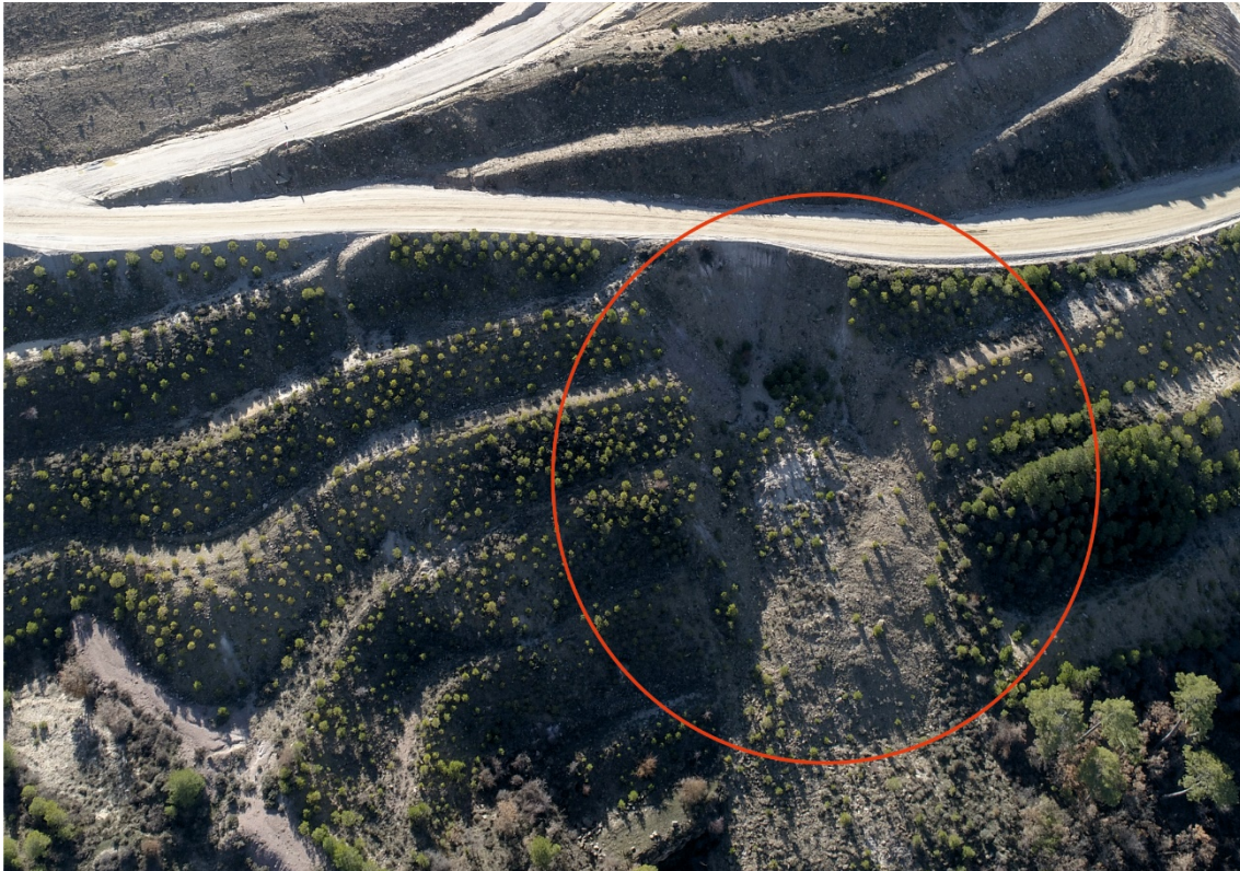
Figura 13. Ejemplos de una restauración en terraza exitosa en términos de estabilidad y establecimiento de vegetación durante más de una década, pero que finalmente terminó experimentando un pequeño deslizamiento.
