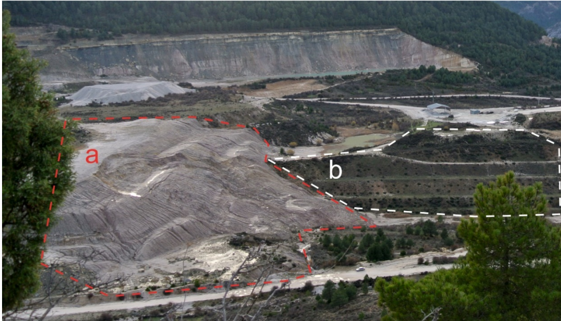
Figura 14. Ejemplo de dos escombreras restauradas en taludes: (a) una de 15 años de antigüedad, situada en el eje principal de un arroyo y sin ningún drenaje subterráneo, y que finalmente terminó experimentando un evidente deslizamiento rotacional; (b) otra de 30 años de antigüedad, situada en el lateral del valle natural y sobre varios drenajes subterráneos, y que en la actualidad permanece estable.
