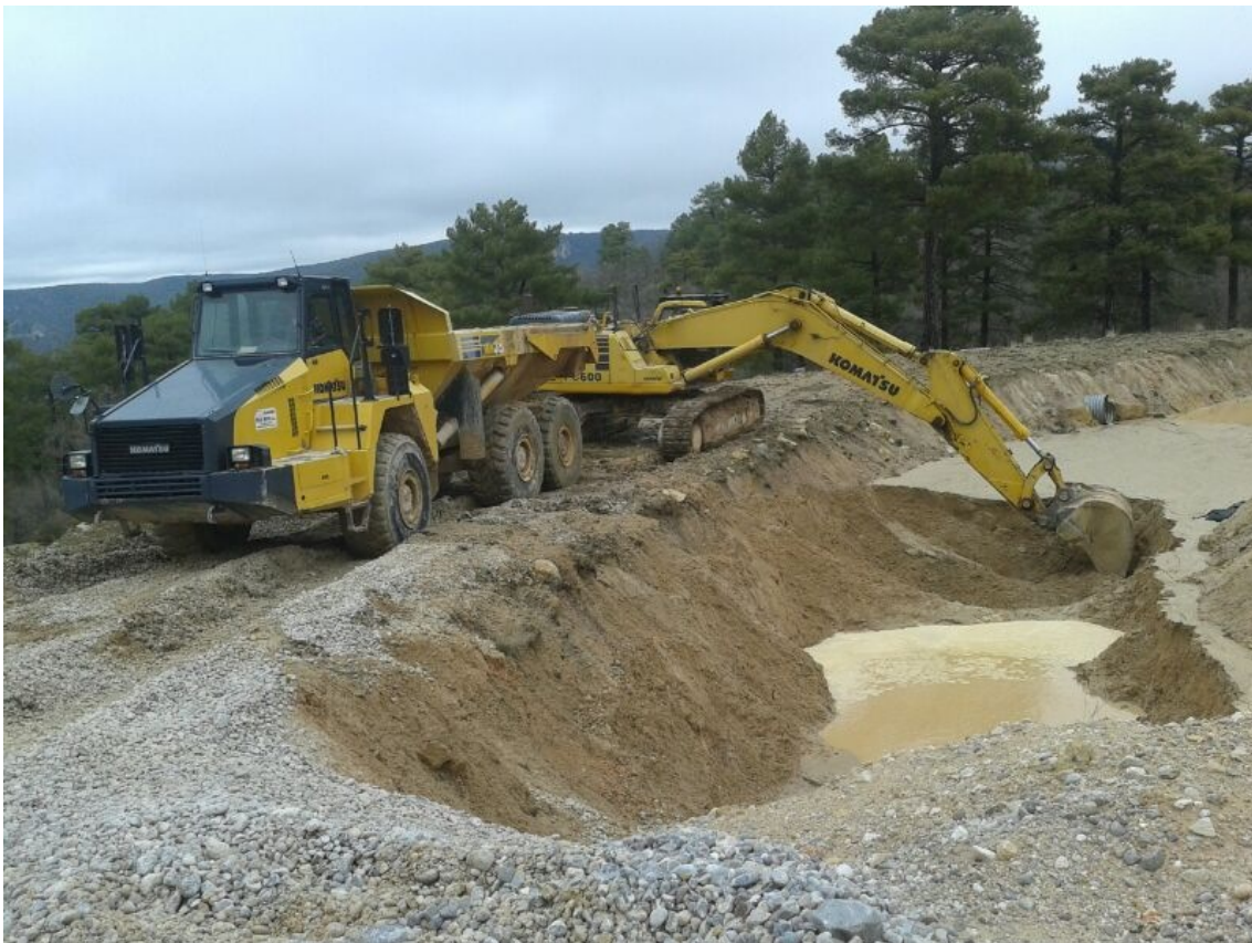
Figura 9. Momento en que los operarios vacían el sedimento retenido por una de las balsas de sedimentación en el interior de una mina. Estas balsas, durante un episodio
