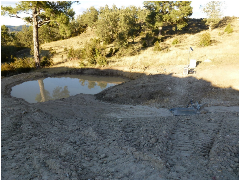
Figura 24. Vista de una balsa de sedimentación construida en la desembocadura de una restauración minera con base geomorfológica para almacenar los sedimentos erosionados durante los primeros años tras la restauración. En este periodo el terreno se está estabilizando, la vegetación crece, y puede experimentar ajustes.
