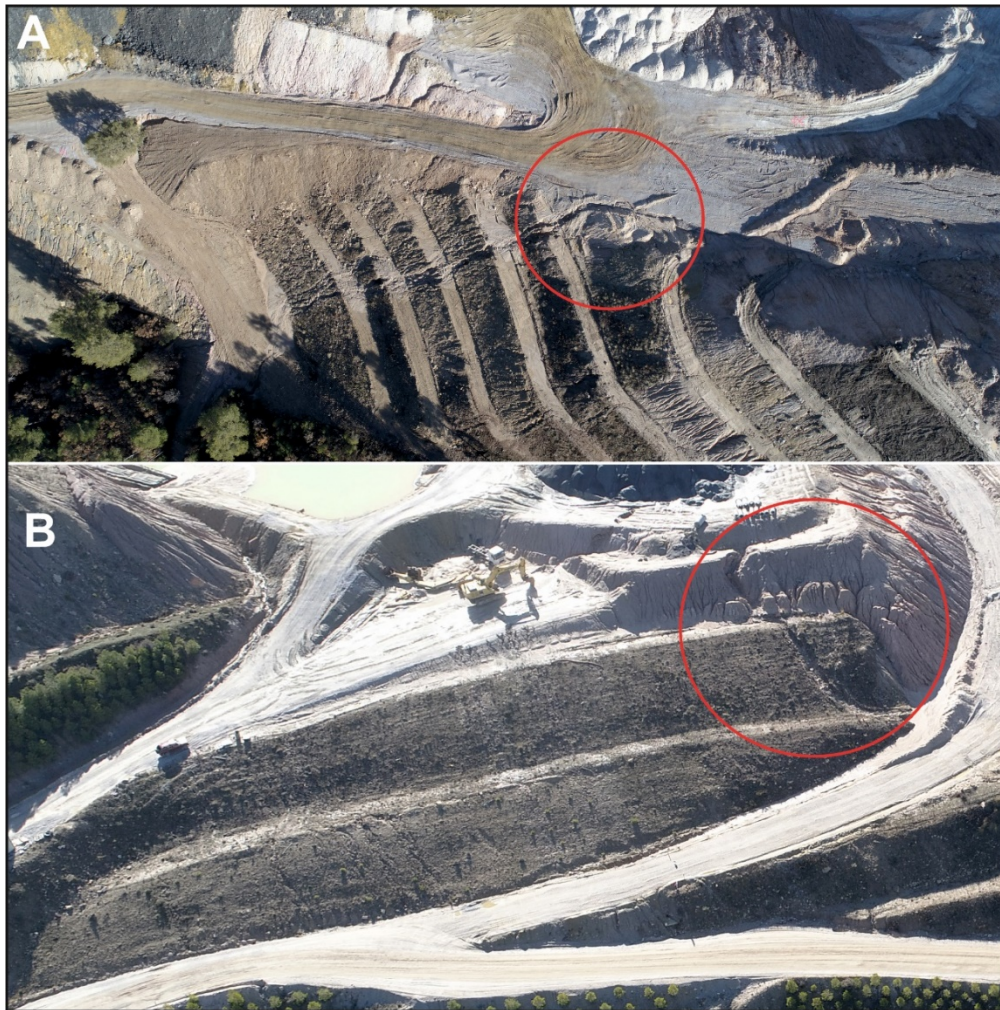
Figura 16. Ejemplo de dos restauraciones en terrazas que han funcionado bien hasta que entradas de agua externas las han erosionado: (A) debido a una pista; (B) debido a la construcción de una escombrera temporal. Fotos tomadas por DGDDRONE.
