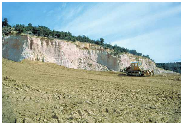
Foto 5. Extendido de depósitos coluvionares sobre la superficie del glacis, reconstruyendo una estructura de ladera similar a la original (ver figura 2). El empleo de maquinaria pesada en el movimiento de las formaciones superficiales obligó a una posterior descompactación de la superficie reconstruida.
