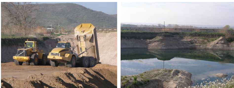
A la izquierda: labores de estabilización. A la derecha: hueco minero retomando el nivel normal de aguas.
